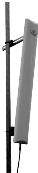
Рисунок 1 – Панельная секторная антенна базовой станции
